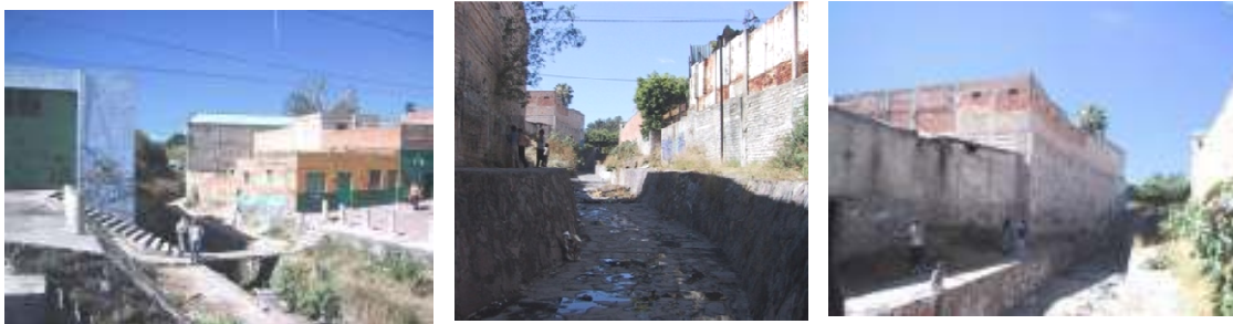
Figuras 4-6: estado actual: abandono y degradación
